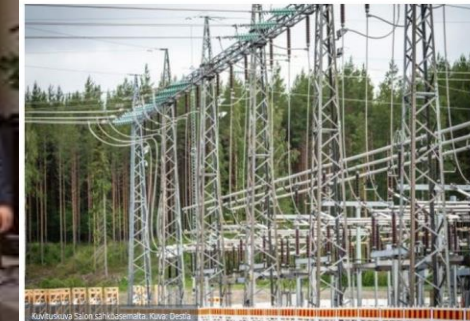
Destia laajentaa Fingridin Pohjois-Pohjanmaan Nivalassa sijaitsevaa Uusnivalan sähköaseman 400 kilovoltin kytkinlaitosta. Yritys rakentaa sinne uuden valvomon ja kolme uutta 400 kilovoltin kenttää sekä tekee varaukset kahdeksi kantaverkkoa vahvistavalle voimajohdolle. Lisäksi projektiin kuuluu koostustöitä.
