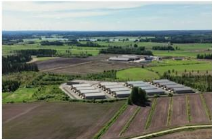
Haapajärven Pysäysperän sähkövarastosta tulee Suomen suurin ja sen on määrä käynnistyä 2027. Akkukontit suojataan lumelta ja jäältä sijoittamalla ne hallien sisään.
