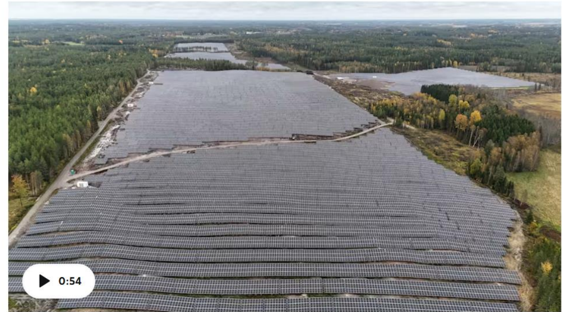
Aurinkopuisto muodostuu 12 paneelialueesta. Voimalan 206 megawatin teho vastaa yli 20 000 kotitalouden sähkön tarvetta. Kuva ja video: Kimmo Gustafsson / Yle
